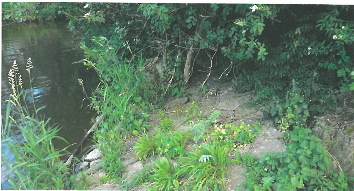
Opevnění pravobřežní části v podjezí, kamenná dlažba – pohled
